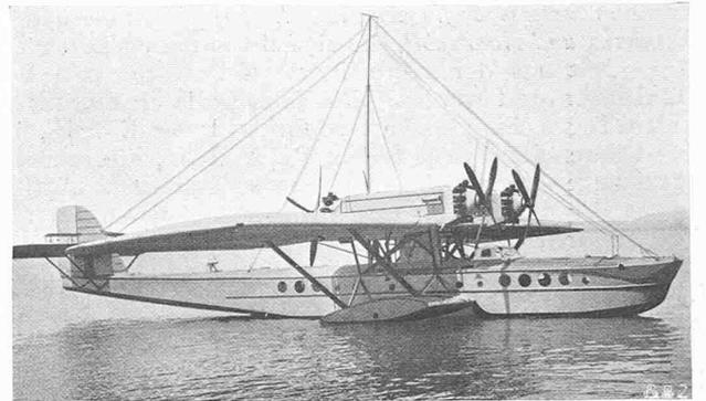
Abb. 2. Flugboot Dornier-Superwal mit Antenne für Radiotelegraphie.
