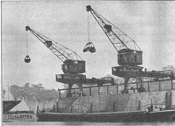
Hafenkrane für Greifer- und Stückgutbetrieb.
