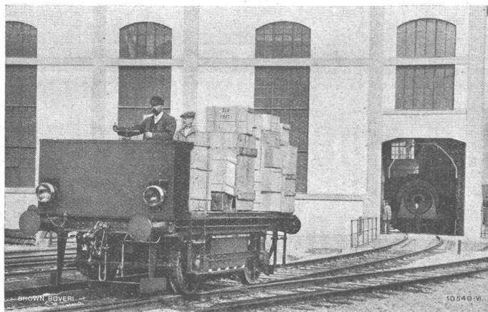
Akkumulatoren - Lokomotive für den Verschiebedienst in den B.B.C.-
