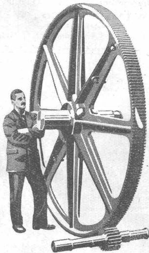
Ritzel mit gehärteten und geschliffenen Zähnen
