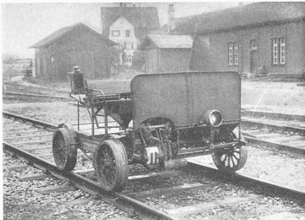
Abb. 3. Motor-Draisine des Leitungsaufsehers.
