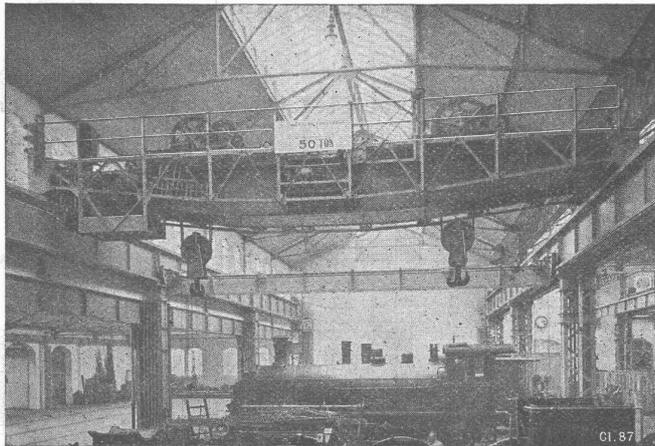
Lokomotivhebekran von 50 Tonnen Tragkraft, in den Reparaturwerkstätten
