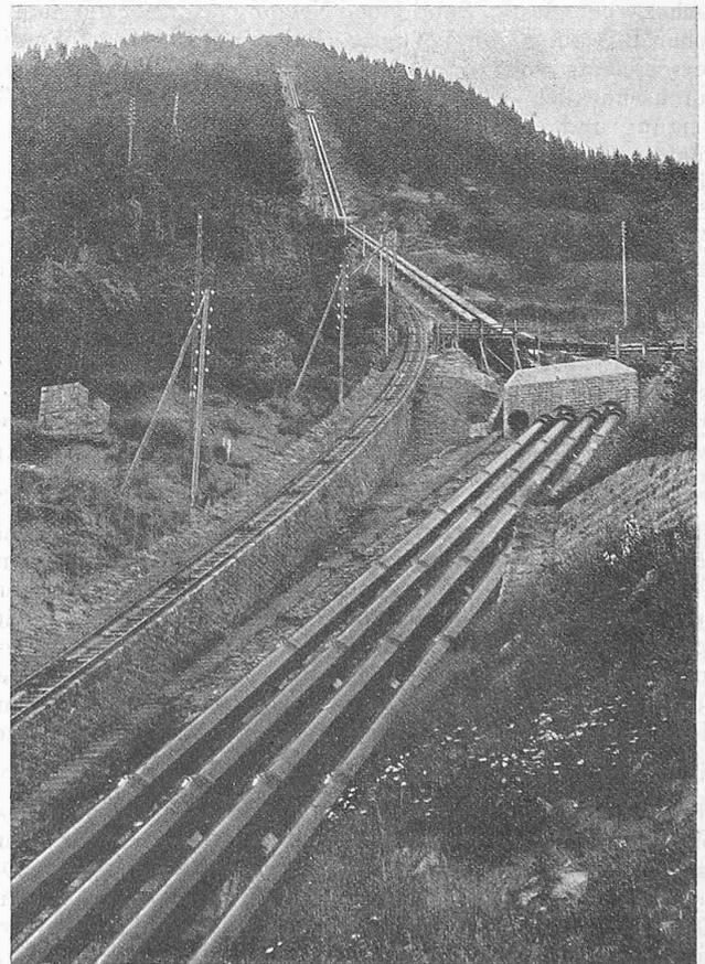
Abb. 29. Die Seilbahn bei Fixpunkt 5 (Gabelung) der Druckleitung.
