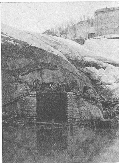
Abb. 9. Einlauf der Wasserfassung (13. V. 1918).
