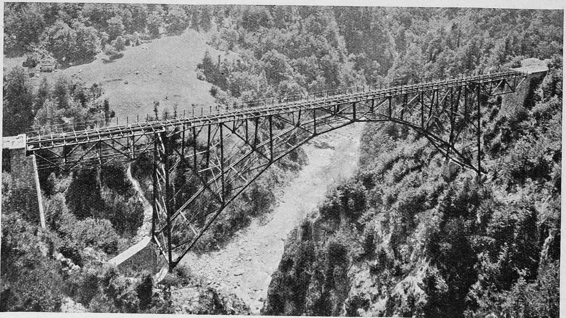
Abb. 2. Die Ruinacci-Brücke bei Camedo an der Centovalli-Bahn, nach Vollendung der Eisenkonstruktion.
