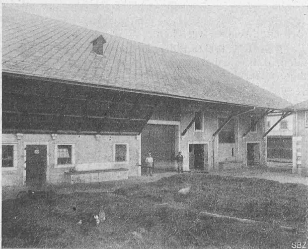
Abb. 2. Rückansicht des Oekonomie-Gebäudes Château des Bois.
