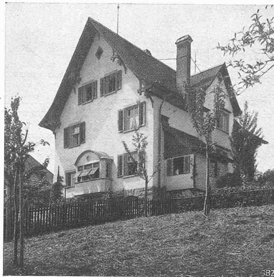
Abb. 7. Haus Maiensäss, von Nordosten.
