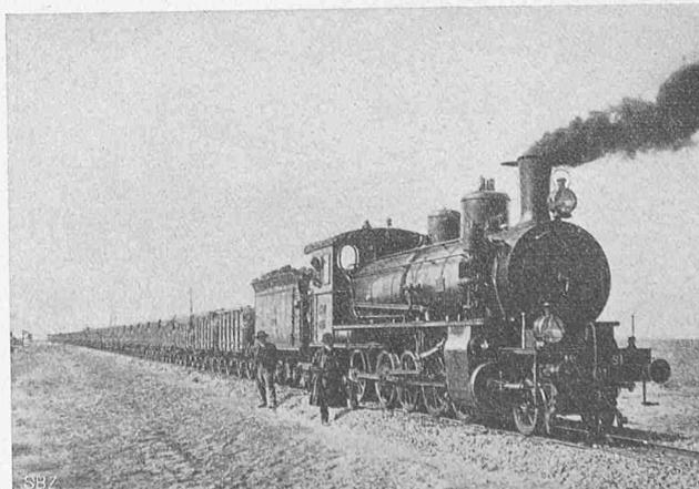
Abb. 2. Probezug mit 81 Wagen und 2004 t Zugsgewicht.
