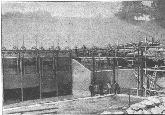
Komplette Fallenzüge für Rheinkorrektion Rorschach. Eisengewicht 52,3 Tonnen.
