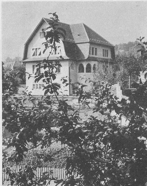
Abb. 7. Ansicht von Süden des Hauses Keltenstrasse Nr. 28.
