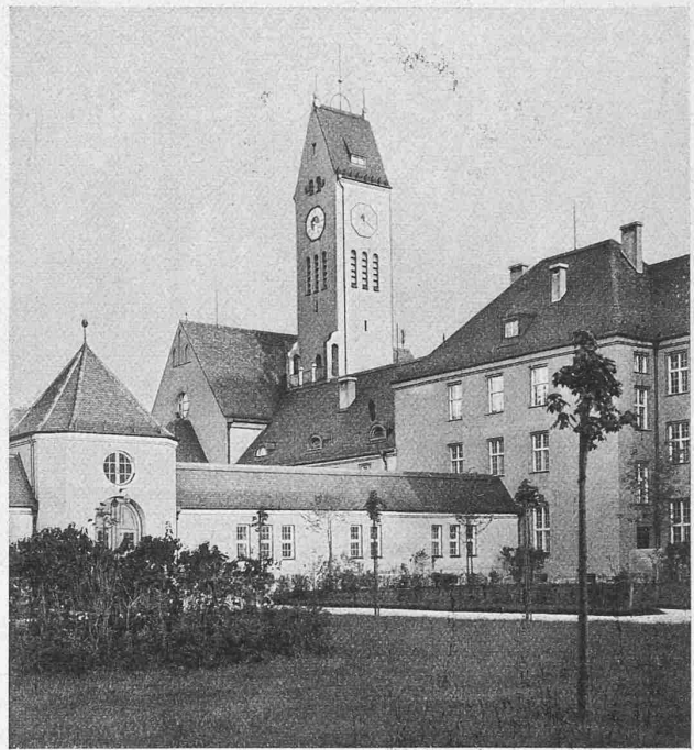
Abb. 13. Kirche mit Hof im Krankenhaus Schwabing.
