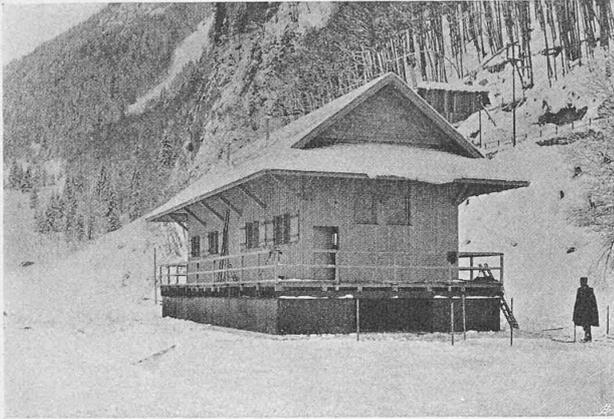
Abb. 112. Schwimmende Pumpanlage im (zugefrorenen) Klöntalersee.
