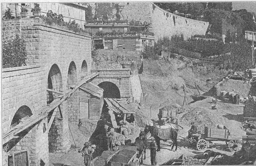
Abb. 15. Stützmauer und Tunneleingang am östlichen Ende des Bahnhofs Montreux.
