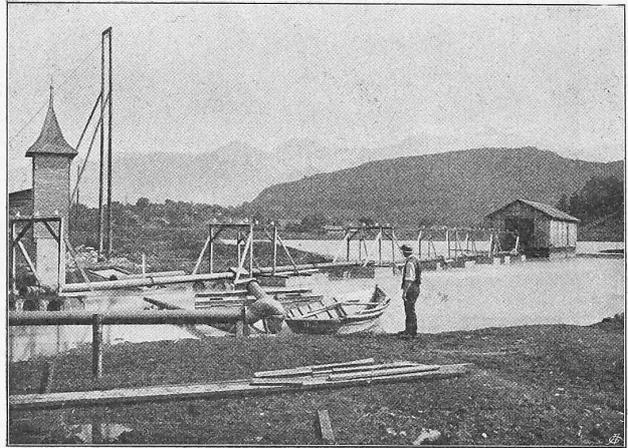
Abb. 48. Schwimmende Rohrleitung vom Baggerschiff zum Wasserschloss.
