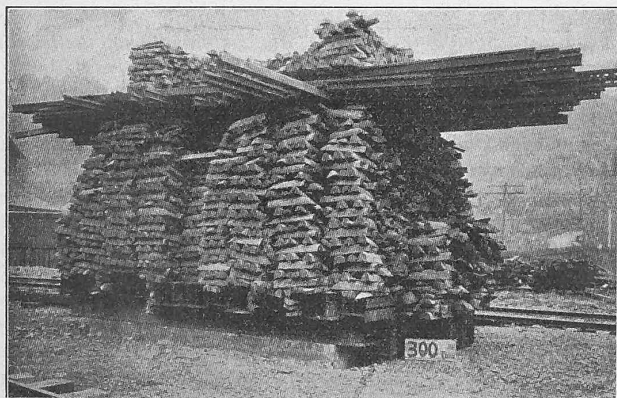
Abb. 50. Probelastung von «Simplex»-Pfählen.
