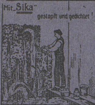
Wasserdurchlässige Böden u. Wände (Putz) werden mit schnellbindender „SIKA“ verdichtet.
