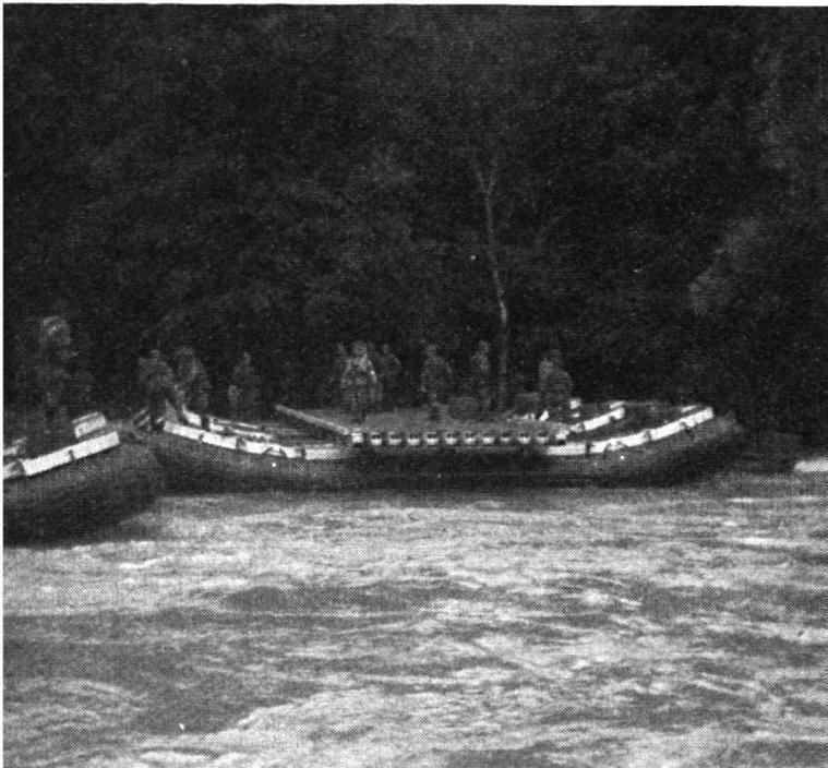
3. Construction d'un pont flottant par une cp pont: amenée d'un élément de pont.
