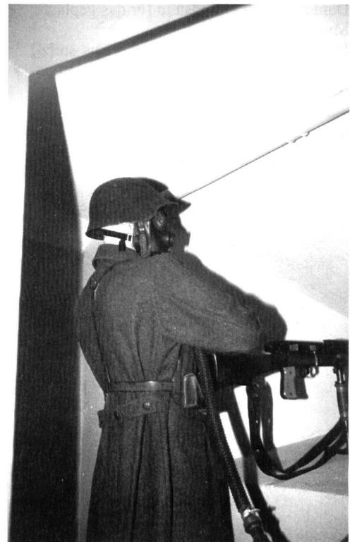
*Eingebauter Maschinengewehrstand. Ueber den Schlauch wird gefilterte Frischluft zugeführt.*
