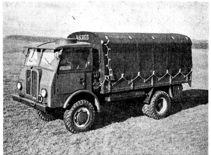
Abb. 3 Geländelastwagen 5 t — 4 × 4, Saurer Dieselmotor, Nutzlast 5 t
