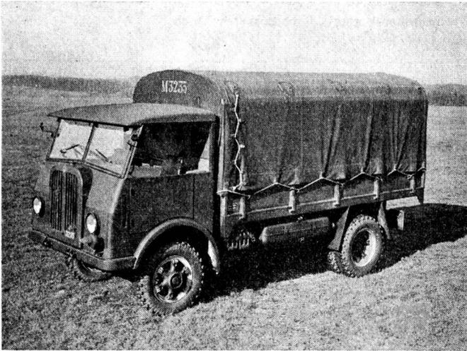
Abb. 2 Geländelastwagen 3 1/2 t — 4 × 4, Saurer Dieselmotor, Nutzlast 3 1/2 t
