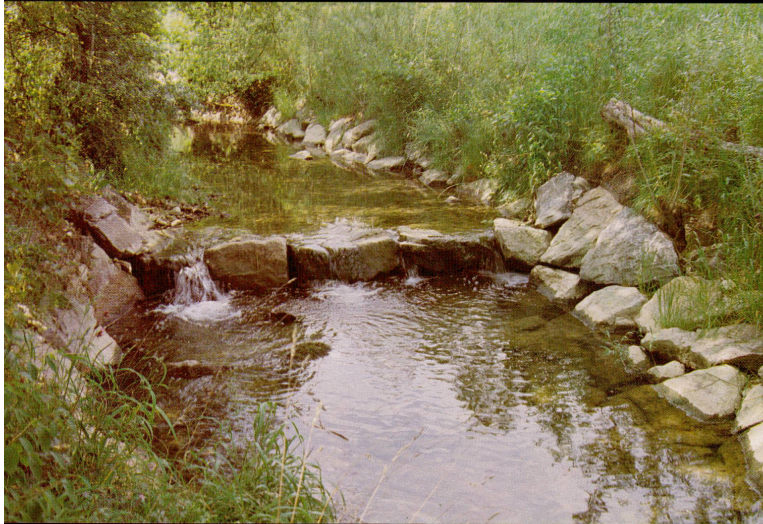
Abb. 14 Naturnahe Verbauung der Ufer mit Steinen
