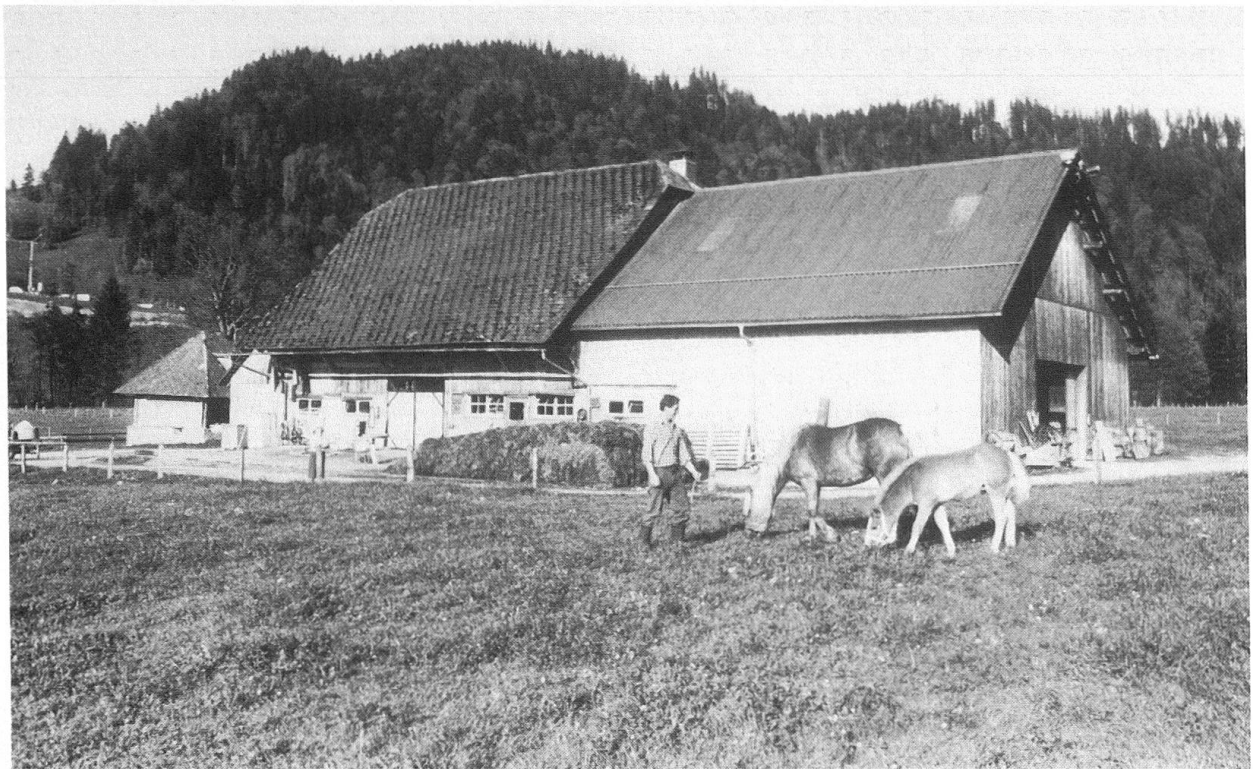
Abb. 3: Sanierter Hof «Linden».
