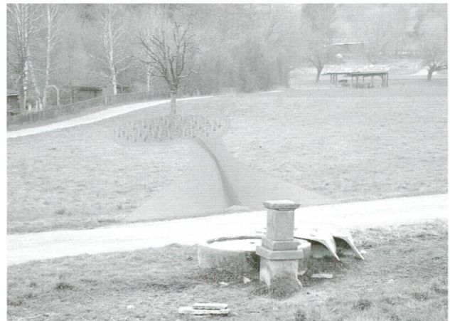
Abb. 6: Offenlegung des Überlaufs aus dem «Kuhtränke»-Brunnen. Das Wasser wird oberflächlich in Richtung Mooswald geleitet. Gleichzeitig wird an der Stelle einer ehemaligen Quelle (vor 1943) die Errichtung eines Quellsumpfs vorgeschlagen.
