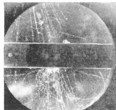
Abbildung 6: Erste Nebelkammeraufnahme eines neutralen V-Teilchens (Rochester & Butler, 1953).
