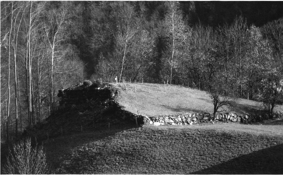
7: Schwanden (GL), Burg Benzigen. Ansicht von Westen.
