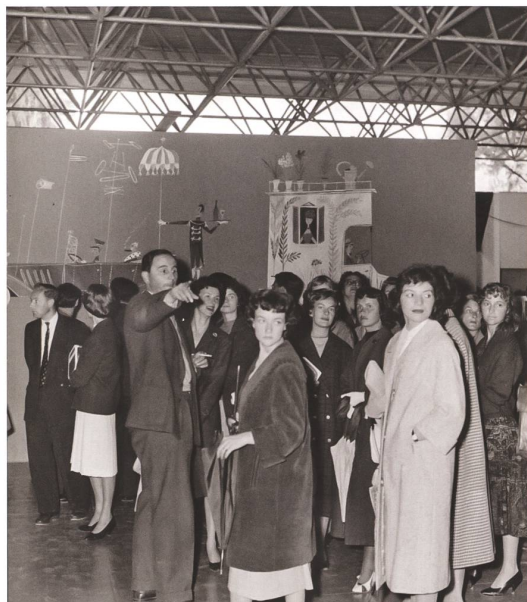
Innenaufnahme des Männerparadieses von Annemarie Hubacher, sichtbar ist die Bedachung mit dem Raumfachwerk Mero (gta Archiv)
