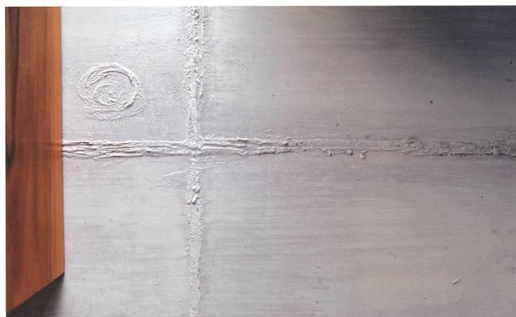
nerseits unschöne Betonoberflächen oder Flickstellen farblich in den Bestand integriert werden, andererseits besteht auch die Möglichkeit, einer sanierten Betonfläche oder Fassade weitgehend das ursprüngliche betonsichtige Erscheinungsbild zurückzugeben. Zudem können damit materialtechnisch andere Flächen ausgezeichnet oder in einen vorhandenen Betonbestand integriert werden.
