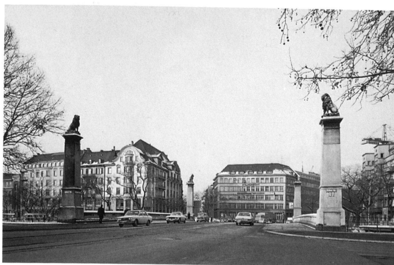
4 Zürich, Stauffacherbrücke. Ansicht von Südosten, Zustand 1980.
