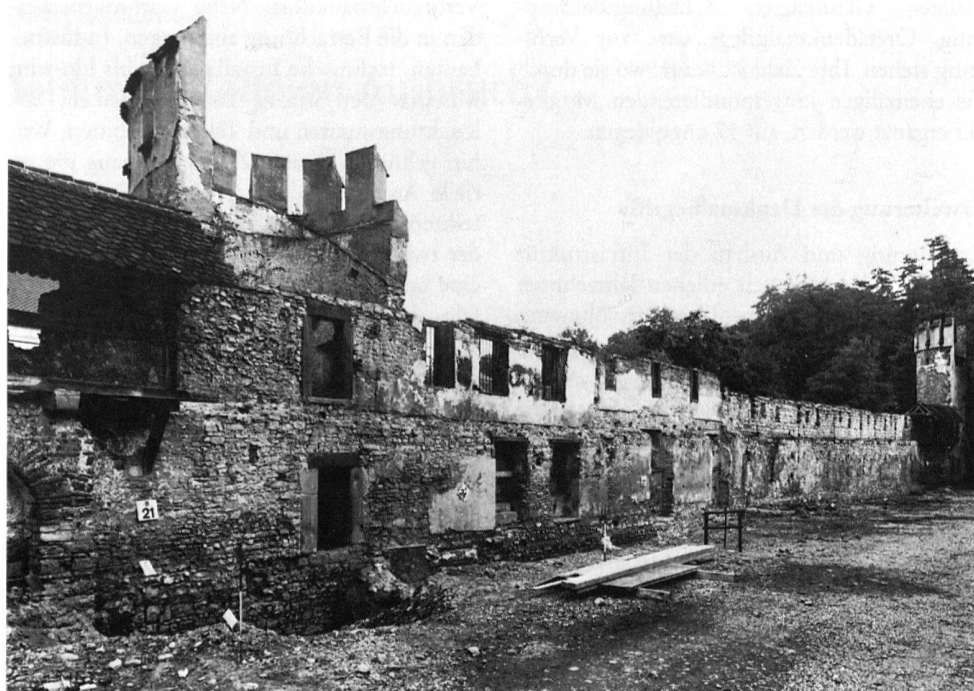
2 Basel, St. Alban-Tal, Wehr- mauer mit Schalentürmen und dem bis auf Reste abgebroche- nen Wehrgang, stadtseitige Sicht vor der Restaurierung.
