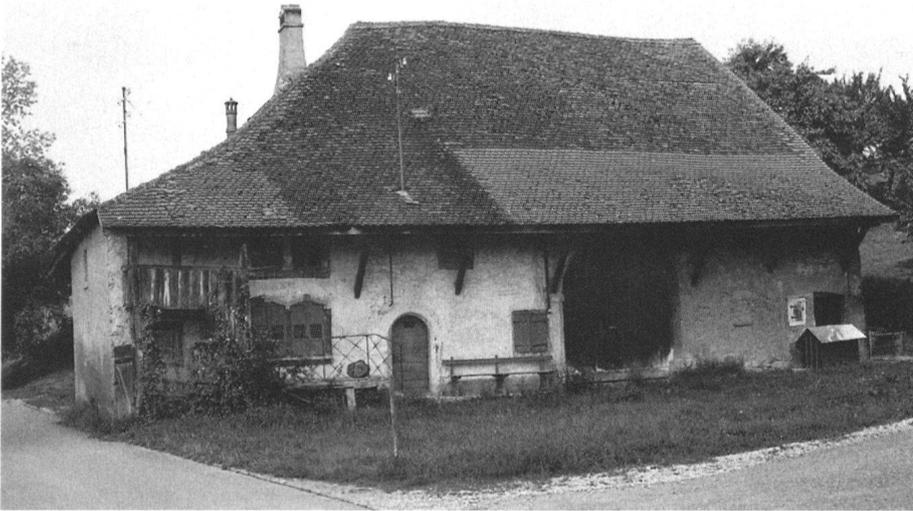
*Châtillon FR, ferme double n° 14/15 avant la démolition, façade est du bâtiment n° 15. – A gauche, l'extension du bâtiment abrite un four; à droite, on observe une porte à linteau cintré en partie murée.*
