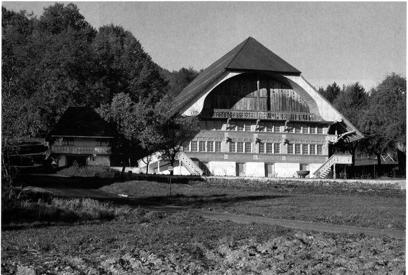
7 Pohlern bei Thun, Rohrmoos, grosses Bauernhaus, erbaut 1775. Nach Verwahrlosung gerettet und durch die Ställe für Bauern- und Dorfkultur 1973–75 restauriert.
