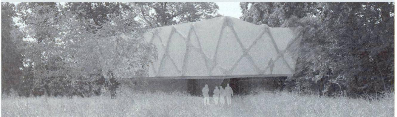
*Marcel Hohl; Konstruktion PVC-Rohre mit Spritzbeton*
