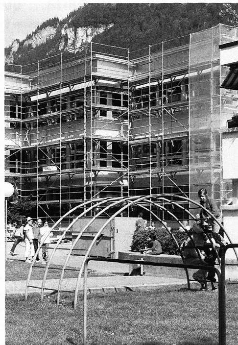
«Bündner Schule in Renovation»
