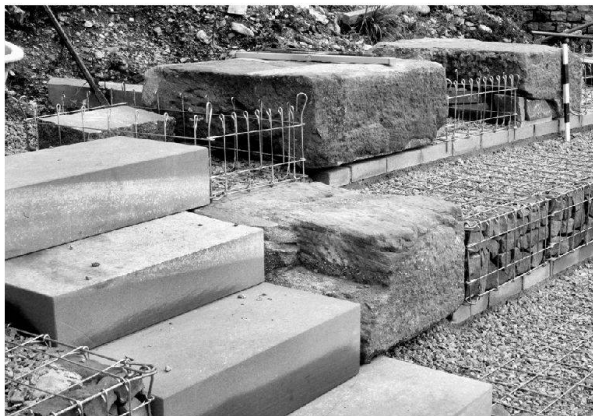
Abb. 28: Augst, Theatersanierung (Grabung 2003.55). Rekonstruktion der Sitzstufen im zweiten Rang. Detail der Aufbauarbeiten in Keil 3. Aus didaktischen Gründen erfolgte eine Integration von drei originalen Sitzstufenquadern aus Buntsandstein in die moderne Gitterkorbkonstruktion.
