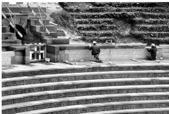
Abb. 24: Augst, Theatersanierung (Grabung 2003.55). Rekonstruktion der Sitzstufen im ersten Rang. Versetzen der Sandsteinabdeckung über der Gürtelmauer der ersten praecinctio.
