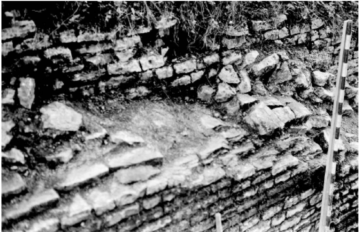
Abb. 9: Augst, Theater. Südost-Vomitorium, Südwanne mit ansteigendem Gewölbeauflager des Tuffsteingewölbes, Zustand nach der Freilegung 1939. Im oberen Bildteil ist deutlich die getreppt ansteigende Widerlagermauer erkennbar. Davor, im Bereich der Mauerschale erodiert, der Bettungskeil für die Kämpferreihe. Links sind noch drei Tuffkeilsteine der Anfängerreihe zu erkennen (vgl. Abb. 10) sowie Reste der Kalksteinfüllung zur Verstärkung der Auflast über den Bogenschenkeln.
