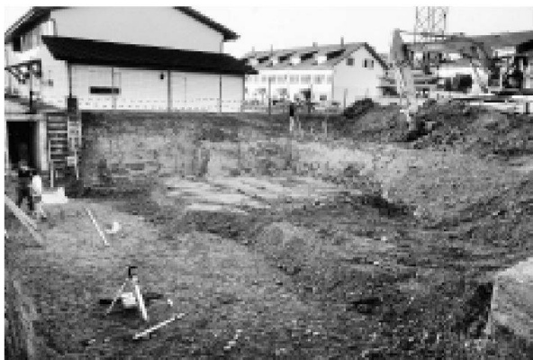
Abb. 3: Kaiseraugst AG, Baugemeinschaft «Römerweg Ost» (Baubegleitung 2001.07). Blick von Norden auf die Süd Hälfte der Baugrube.
