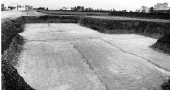
Abb. 8: Kaiseraugst AG, Konsortium «Kaisergarten», Überbauung 1. Etappe, Violahofweg (Baubegleitung 2001.16). Blick von Süden in die Baugrube.
