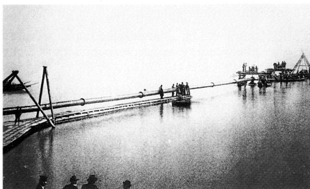
Abb. 11 St. Gallen. Bodenseewasserleitung 1896 zur Versorgung der zirka 260 m höher liegenden Stadt. Erstes Ausfahren der Seeleitung im «Riet» bei Rorschach am Bodensee am 16. August 1896.
