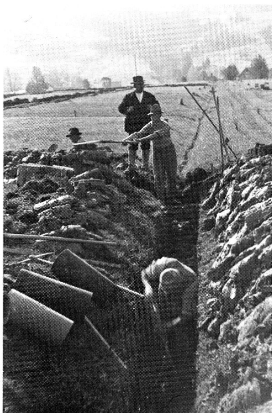
Legen der Entwässerungsröhren
