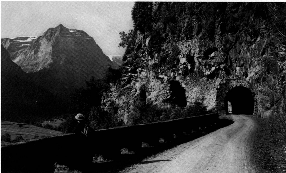
Klausenpass-Strasse: Blick Richtung Selbsanft.
