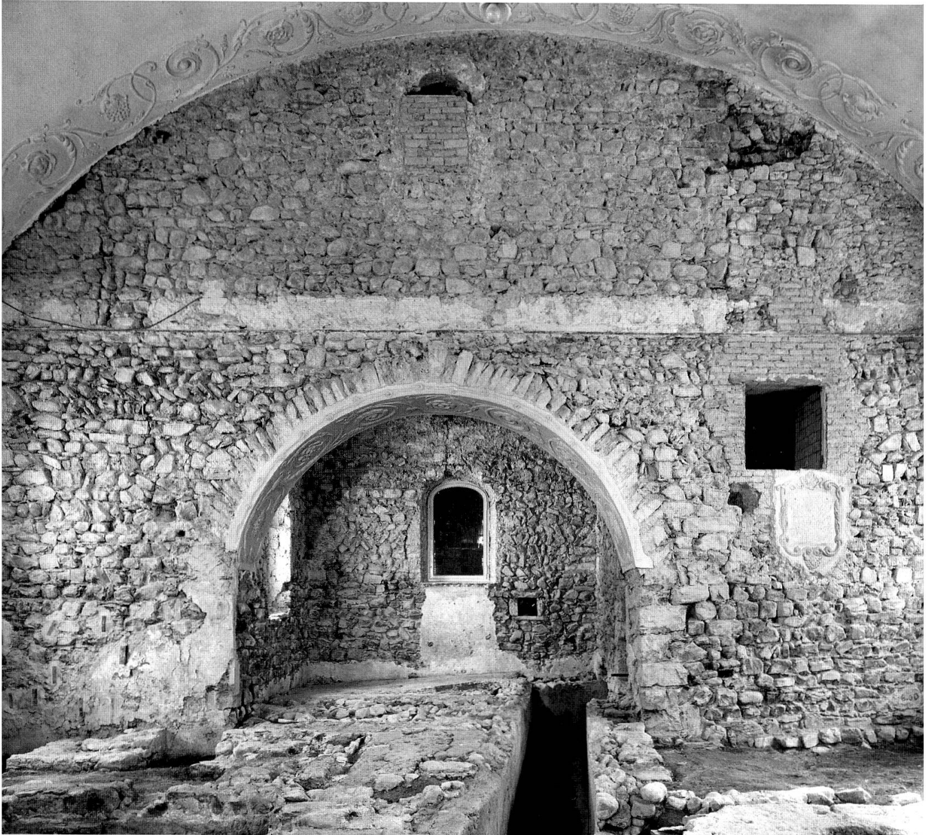
Abb. 3: Die Südmauer des Schiffes mit Chorbogen. An der linken Seite des Bogens ist der Charakter des Mauerwerks der ursprünglichen Kirche deutlich ersichtlich.
