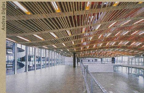
Das Holzdach des Arch-Tec-Lab der ETH wurde programmiert und von Robotern konstruiert.
