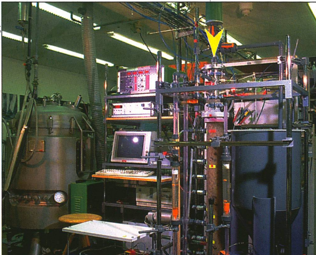
Installation-pilote d'épuration par biofiltre. A gauche, la cuve contenant les eaux usées; le biofiltre est indiqué par la flèche.
