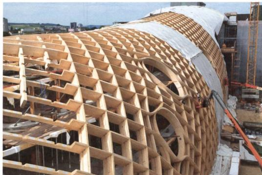
Die Dachkonstruktion besteht aus 4600 unterschiedlichen Elementen.
