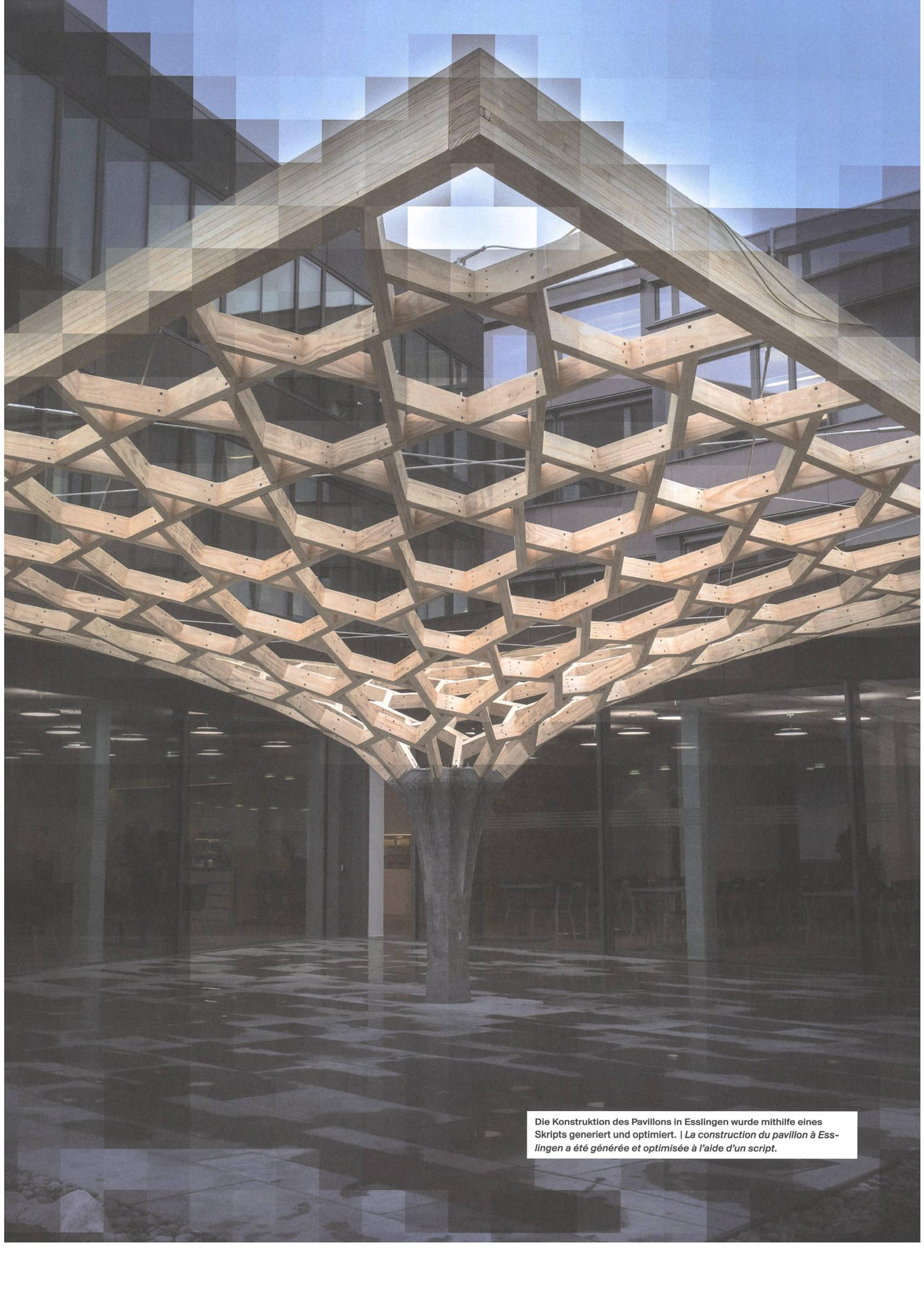
Die Konstruktion des Pavillons in Esslingen wurde mithilfe eines Skripts generiert und optimiert. | La construction du pavillon à Esslingen a été générée et optimisée à l'aide d'un script.
