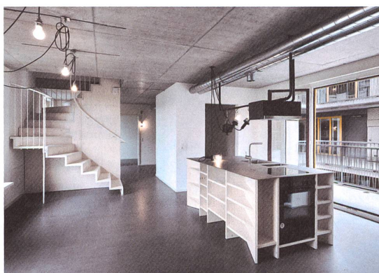
Küchenblock und Treppe sind aus Holzplatten gebaut.
