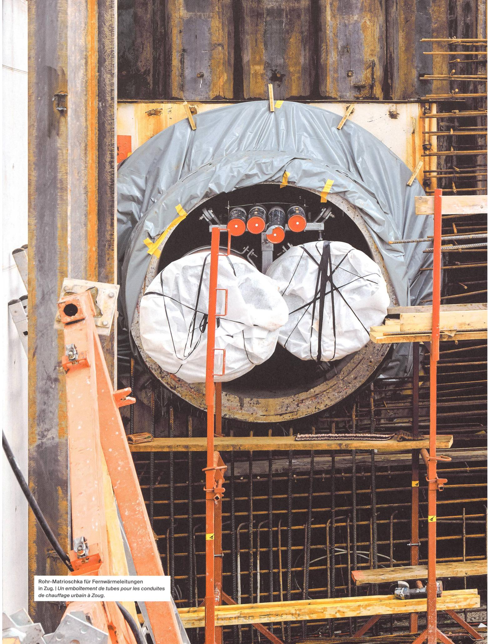
Rohr-Matroschka für Fernwärmeleitungen
