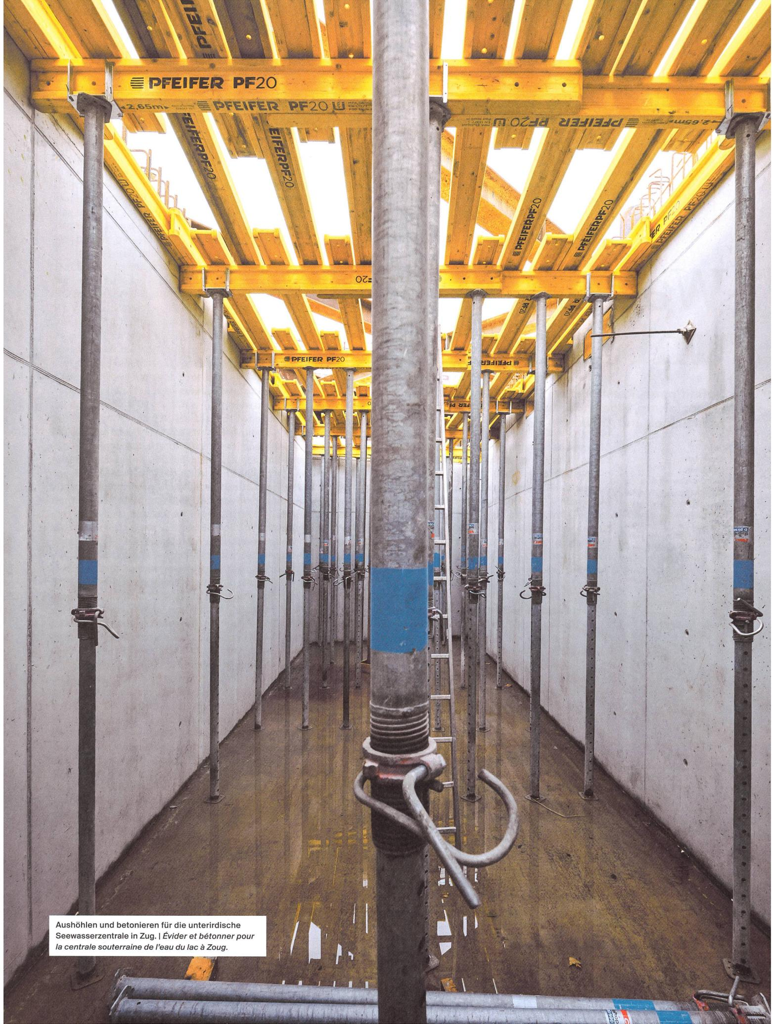
Aushöhlen und betonieren für die unterirdische Seewasserzentrale in Zug. | *Évider et bétonner pour la centrale souterraine de l'eau du lac à Zug.*
