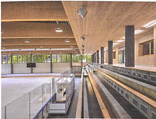
26 Das Holzdach sitzt auf Betonstützen.
